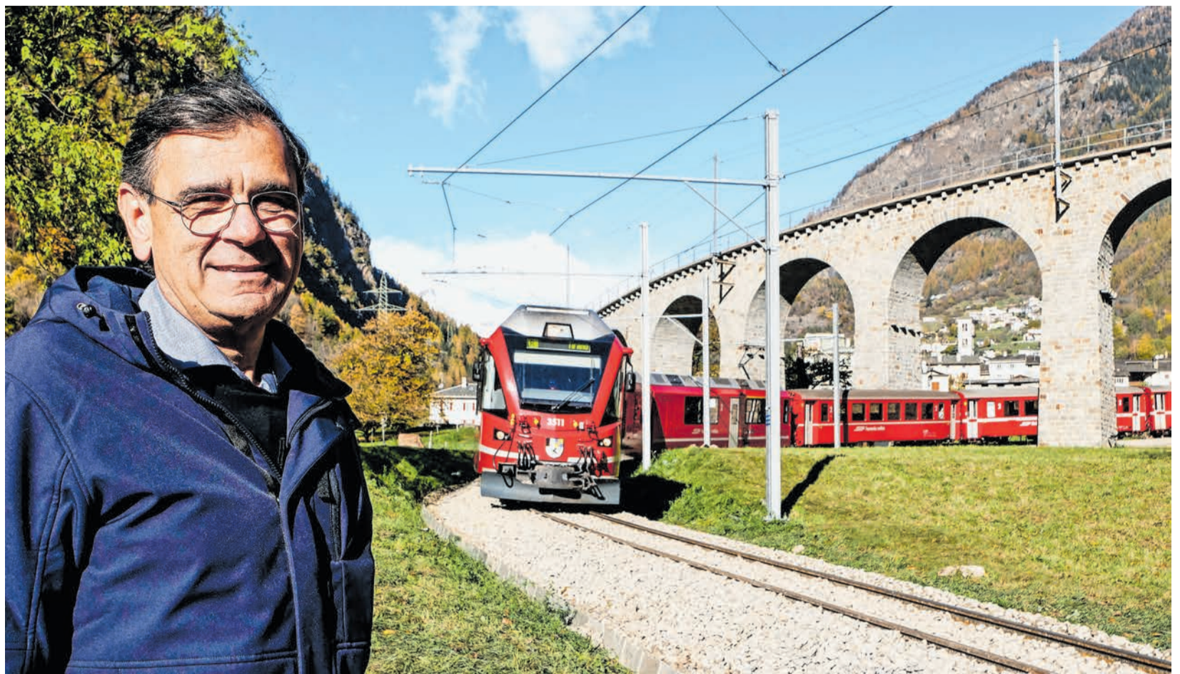
Livio Zanolari vor dem Kreisviadukt der Rhätischen Bahn in Brusio, «einem Bauwerk allerhöchster Ästhetik». Er bedauert heute einzig, bei seinem Vorschlag 2002 nicht gleich das ganze RhB-Streckennetz als Unesco-Welterbe vorgeschlagen zu haben.
