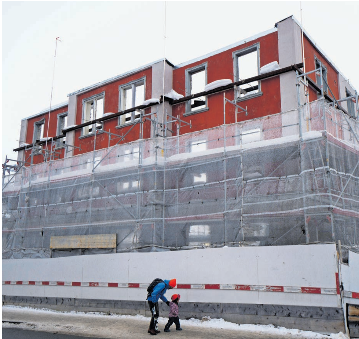
Seit Oktober 2019 ruhen die Bauarbeiten beim ehemaligen Hotel Misani in Celerina. Jetzt ist ein neues Baugesuch eingegangen. Gemäss diesem sollen die Arbeiten im kommenden Frühjahr fortgesetzt werden. Foto: Reto Stifel
