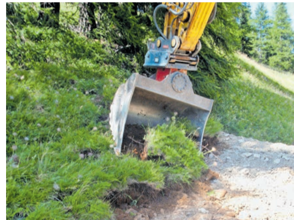
Links: Vegetationsziegel nach erfolgter Renaturierung am Berninapass. Rechts oben: Maschinelles Eintragen der Ziegel am Julierpass, unten Ziegel mit geschützten Türkenbund-Orchideen in Silvaplana.
