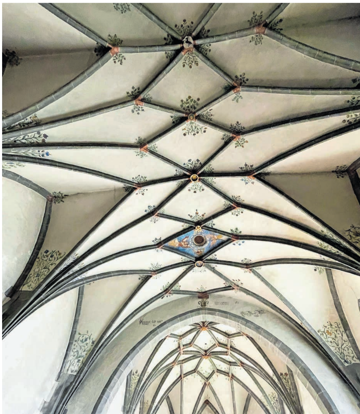
Die spätgotische Gewölbekonstruktion im Langhaus und Chor.
