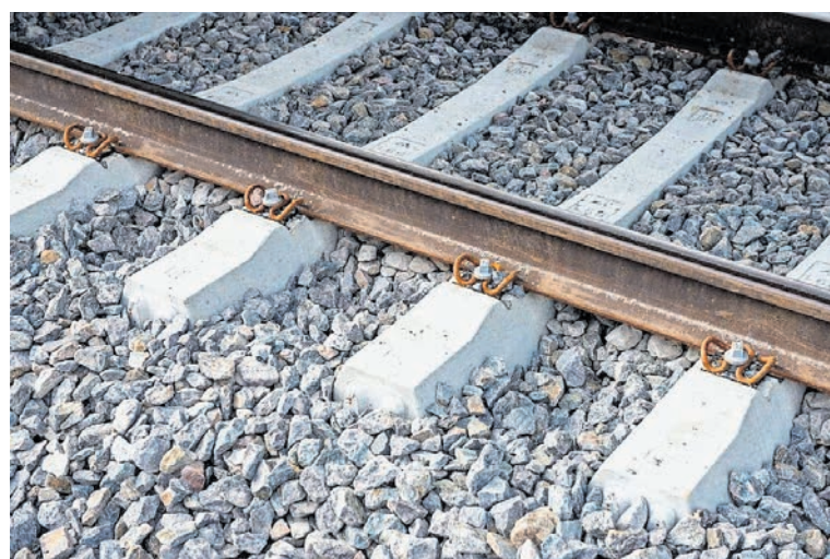
Las traversas convenziunalas sun da betun. Da nouv daja uossa eir da quellas da material sintetic.
