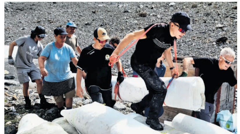
Gewichte an den Rändern der Abdeckung sollen das Wegwehen durch Sturm verhindern. Bis zu 10 Personen sind notwendig, um die Fleeceabdeckung zu bewegen.
