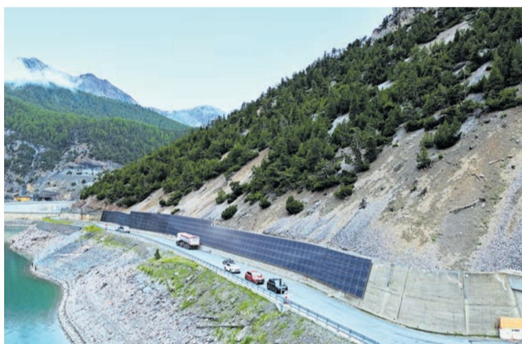
Visualisaziun da l'implant fotovoltaic da las OEE in vicinanza da la Punt dal Gall.
