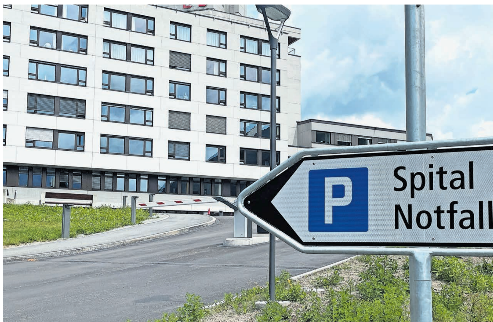
Das Spital Oberengadin in Samedan sorgt für Negativschlagzeilen.
