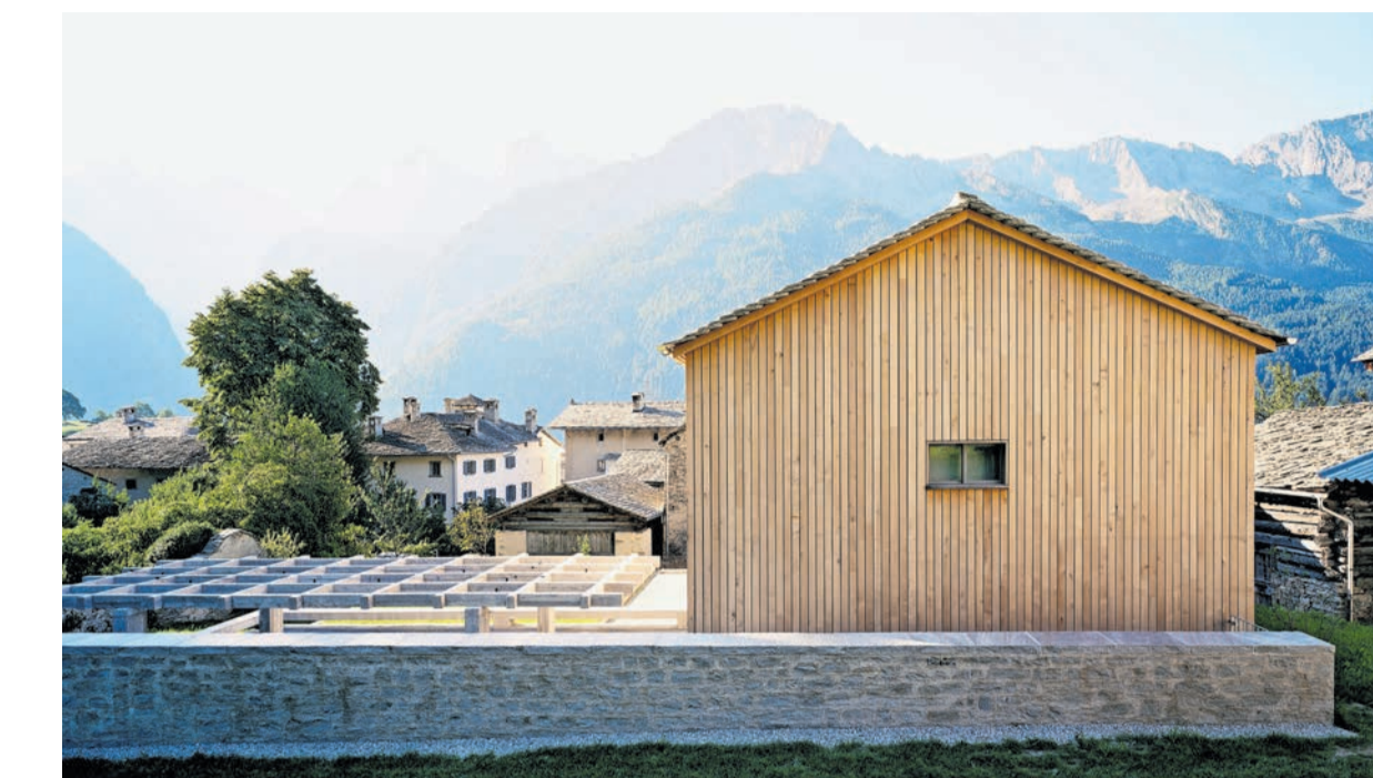
Haus und Atelier Meier in Soglio.
