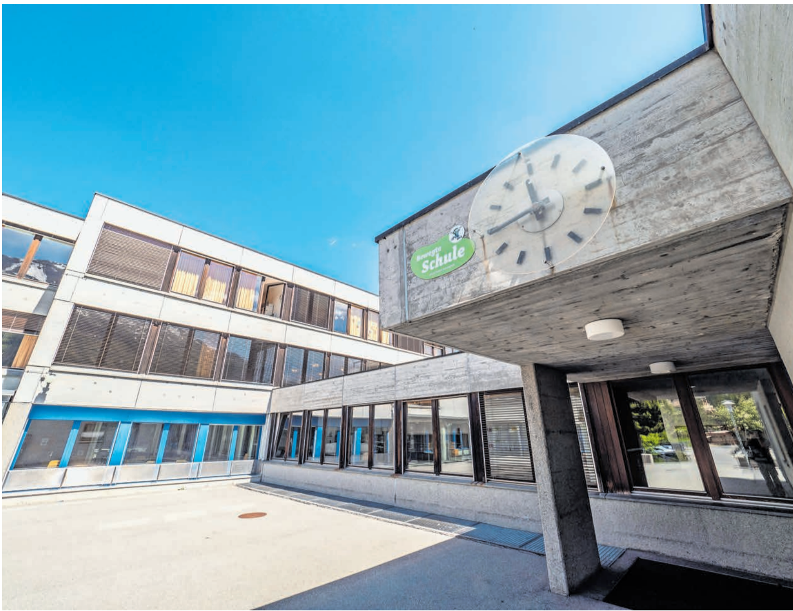
Das über 50-jährige Schulhaus Grevas in St. Moritz sollte gemäss den ursprünglichen Plänen durch einen Neubau ersetzt werden. Doch zurzeit ist das Verfahren sistiert. Die Frage nach der Zukunft der Oberstufen-Schule wird nun aus einer regionalen Optik betrachtet.
