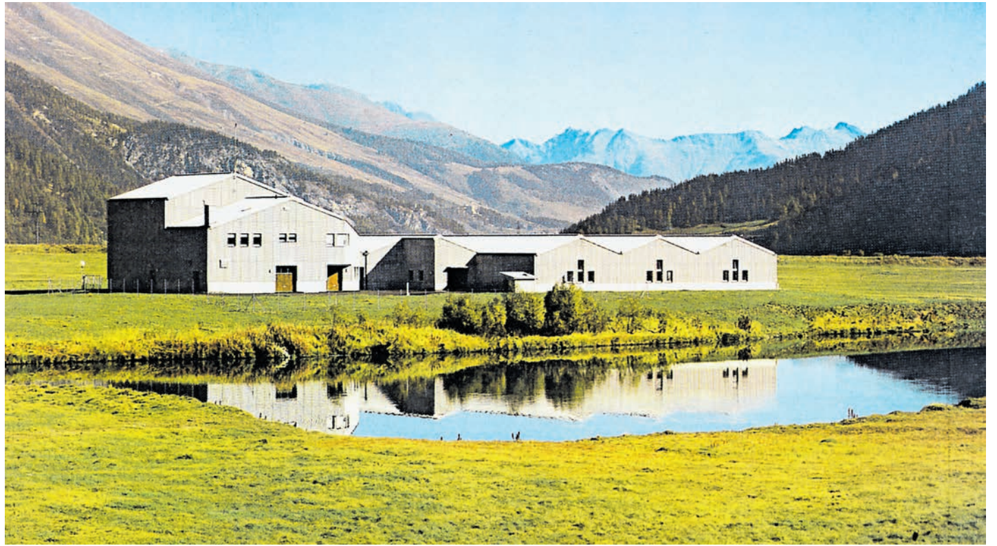
Das Ensemble der im Herbst 1984 in Betrieb genommenen ARA Sax zwischen Bever und Samedan mit aufkeimenden Bäumen am Seeufer...
