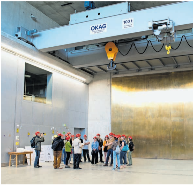
Die riesige Montagehalle des Unterwerks Albanatscha mit dem monolithischen Tor, welches innen immer noch schön golden ist. Fotos: Reto Stifel
