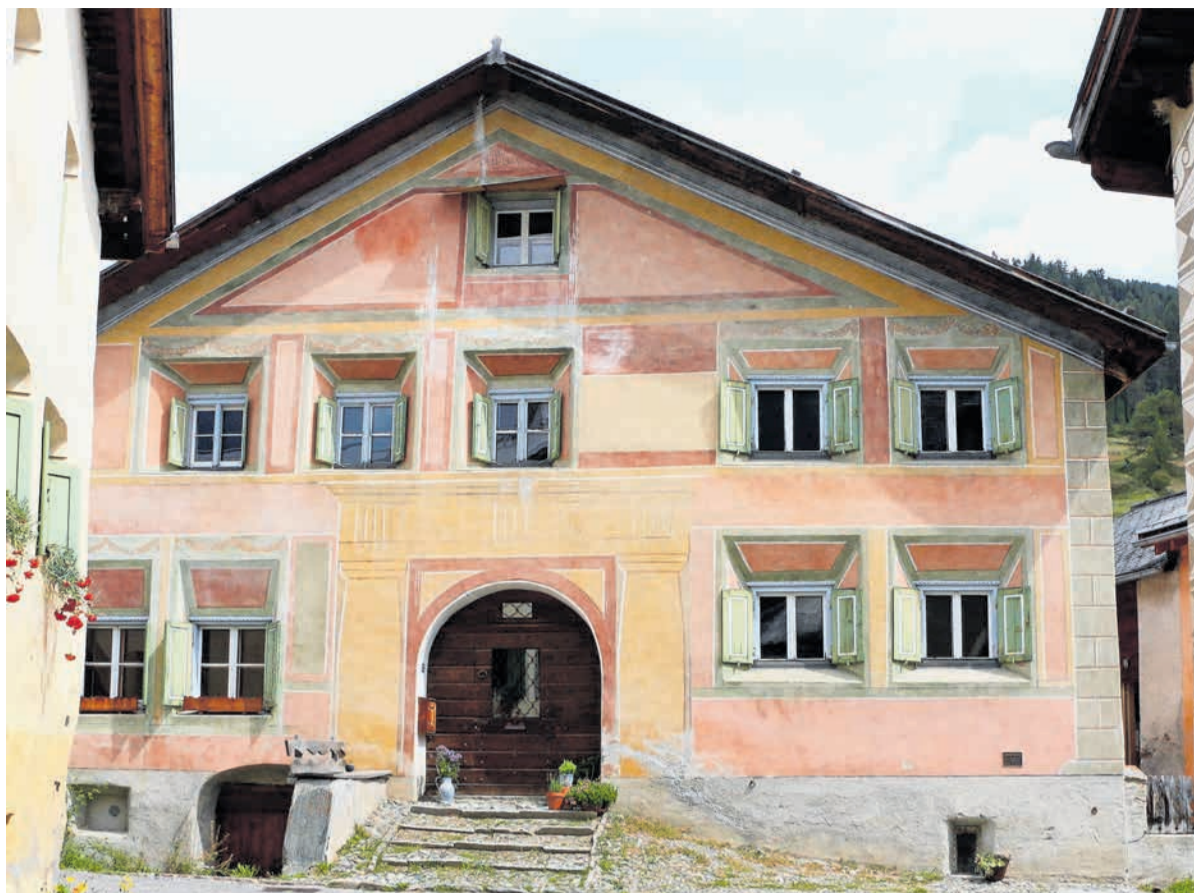
La Chasa Torel es üna chasa culurida e marcanta immez Guarda. Ella dess gnir sanada ed spordscher in avegnir i'l tablà üna o duos ulteriuras abitaziuns primaras. fotografia: Urs Padrun
