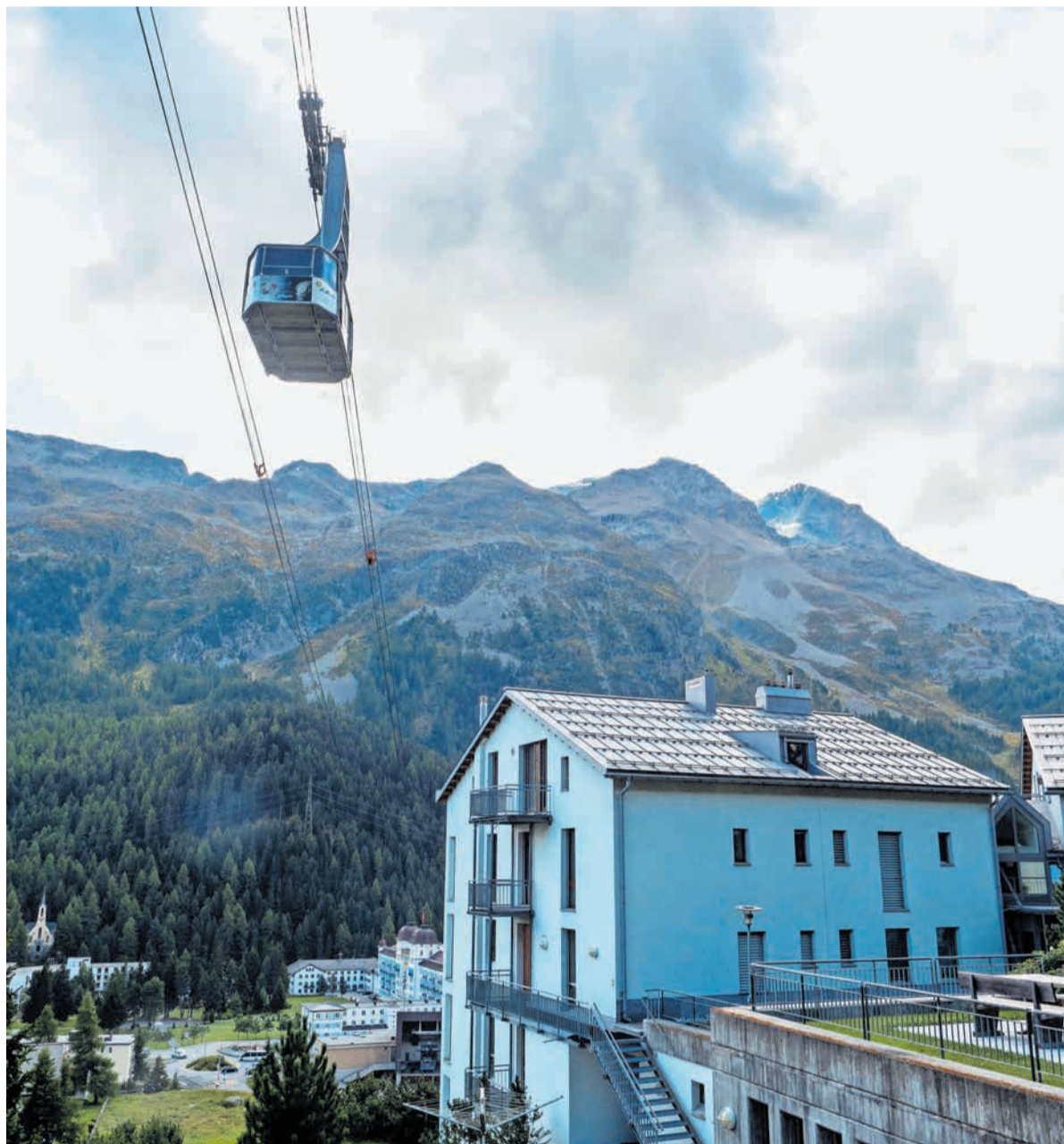
Die über 50-jährige Signalbahn kann nicht durch eine Gondelbahn ersetzt werden.
