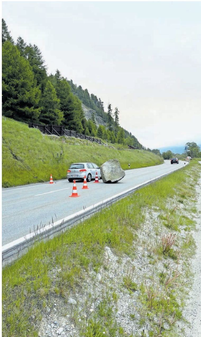
Der grössere der beiden Gesteinsbrocken, welcher die Kantonsstrasse erreichte, hat ein Volumen von rund vier Kubikmeter. Foto: Andrea Gutgsell
