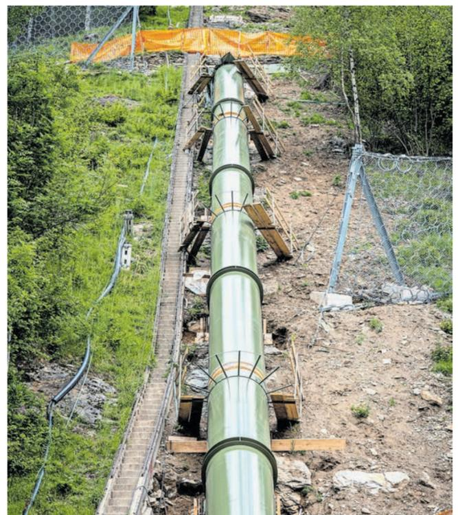
Die Druckleitung Balbalera nutzt den Cavagliasco-Fall mit 600 Metern Gefälle. Das neue, grössere Druckrohr ersetzt die bisherigen beiden Röhren.
