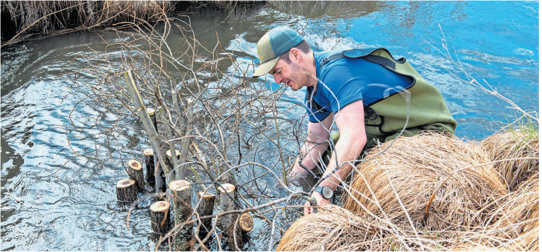
Diese am Hegetag gebaute Buhne sorgt im Saxbach für eine bessere Strömungsvariabilität.
