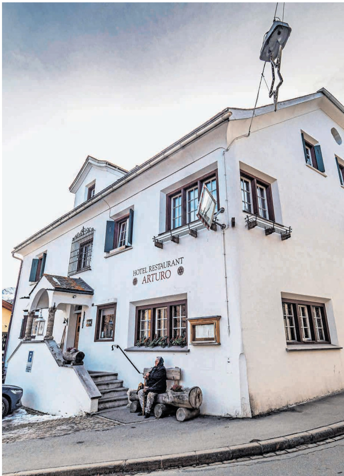
Das Schicksal des Hotel-Restaurants Arturo in Celerina ist besiegelt: Es schliesst in einem Jahr und wird anschliessend zu einem Wohnhaus umgebaut. Foto: Daniel Zaugg
