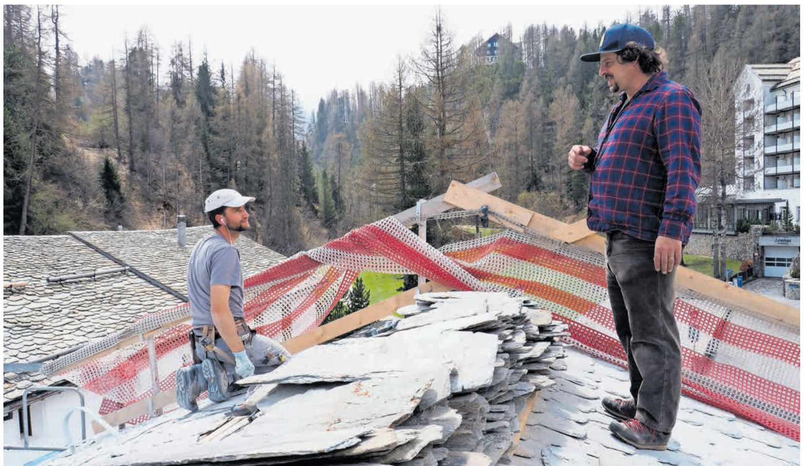
Der Schiefer aus der Val Malenco besticht durch seine blaugrüne Färbung (oben). Dachdecker Mario Looser sucht die Platten nach bestimmten Kriterien aus und befestigt diese mit Hammer und Nagel (oben rechts und Mitte). Claudio Meuli ist Inhaber und Geschäftsführer der Meuli AG in Sils (unten).
