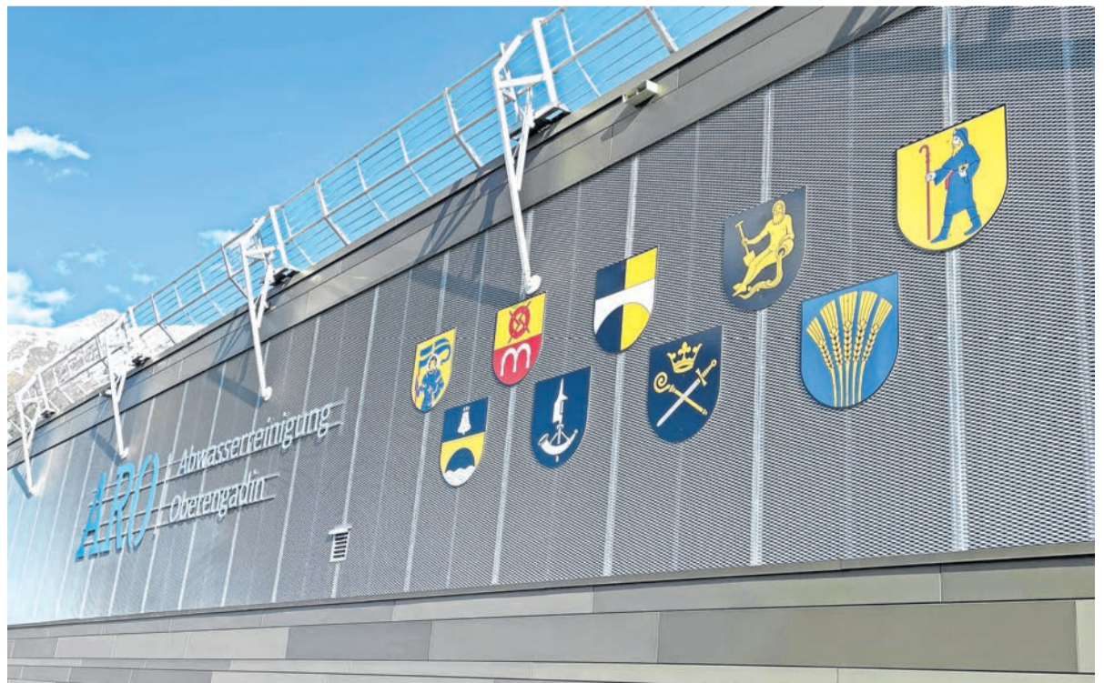
Die Delegierten der Abwasserreinigung Oberengadin (ARO) haben am Donnerstag einen Kredit für die Sonderbauwerke genehmigt.
