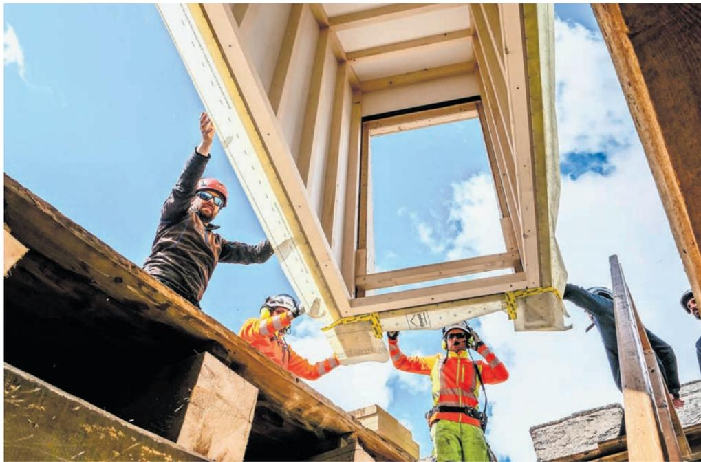
Flughelfer der Heli Bernina und Mitarbeiter der Holzbaufirma Nusser manövrieren das «heranschwebende» Element des neuen Dachausstiegs punktgenau auf die vorbereitete Dachöffnung.
