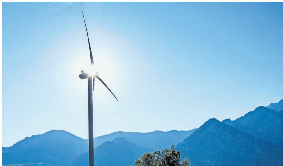
Das einzige Bündner Windkraftwerk «Calandawind» in Haldenstein liefert jährlich rund 4,5 GWh Energie. Das sind gerade einmal 2,5 Prozent des Bündner Ausbauziels von 400 GWh bis ins Jahr 2050.
