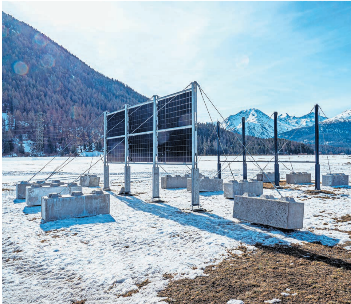
Die Musterpanels auf der vorgesehenen Fläche neben dem Flughafen in Samedan.
