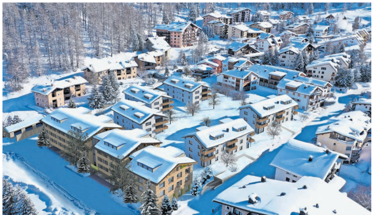
Die Überbauung Foppas Ost in einer Visualisierung. Vorne ist der Hotelriegel ersichtlich, welcher das Quartier in Richtung West abschliessen wird.
