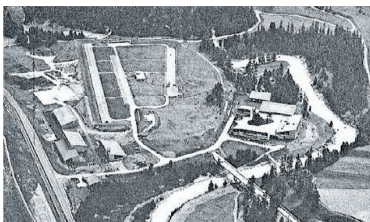
Das Ensemble des Flab-Schiessplatzes S-chanf nach Inbetriebnahme 1976 aus der Luft betrachtet. Foto: Archiv Schweizerische Bauzeitung/ePeriodica
