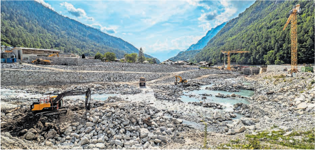
Bauarbeiten im neuen Auffangbecken in Bondo.
