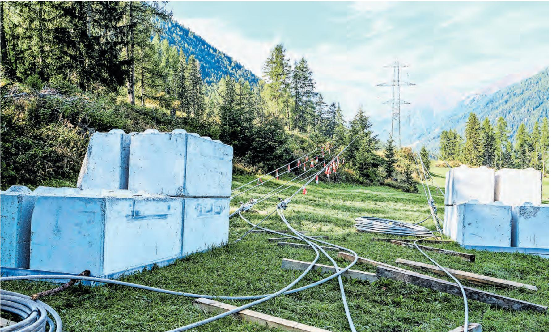
Sicht von der Baustelle des Mastes Nr. 68 in Zernez Selva in Richtung Oberengadin. Die Leiterseile der Höchstspannungsleitung sind ausgezogen und mit schweren Gewichten am Boden befestigt. Sobald der neue Mast steht, werden die Leiterseile und das Erdseil neu aufgezogen und befestigt.
