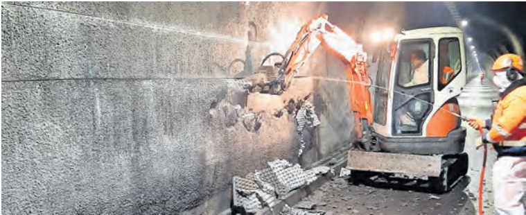
Per pudair finir las lavuors da sanaziun dal tunnel Munt La Schera es il tunnel serrà dal principi da settember fin als 24 november. fotografia: OEE
