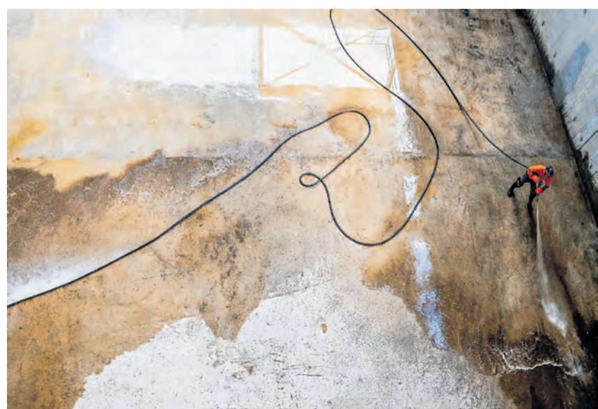
Ein Blick von oben ins sechste, noch leere SBR-Reaktorbecken lässt die Dimension des 3600 m 3 grossen Betonbeckens ansatzweise erahnen.
