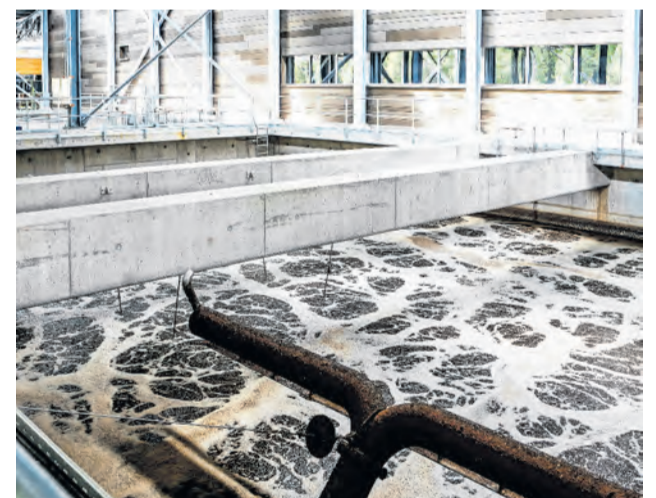
Blick auf die zum Schutz der Hallenkonstruktion vor Korrosionsschäden hermetisch verschlossenen Vorklärbecken (links) und in eines von fünf aktiven SBR-Biologie-Reinigungsbecken, einen sogenannten «Sequencing Batch Reactor».
