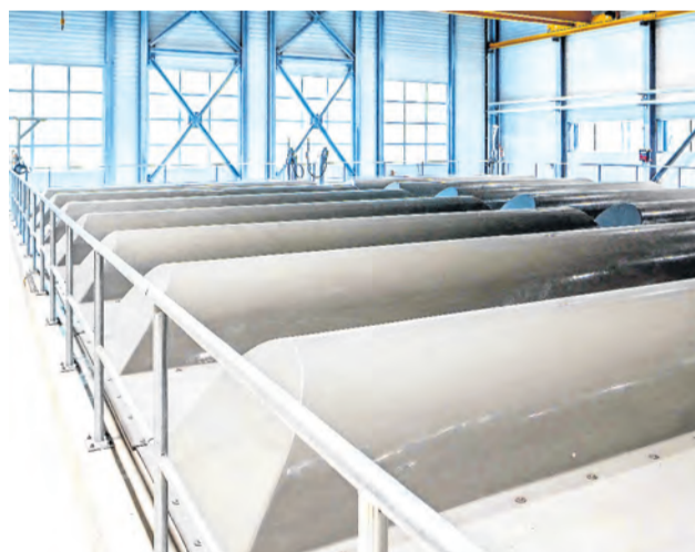
Blick auf die zum Schutz der Hallenkonstruktion vor Korrosionsschäden hermetisch verschlossenen Vorklärbecken (links) und in eines von fünf aktiven SBR-Biologie-Reinigungsbecken, einen sogenannten «Sequencing Batch Reactor».
