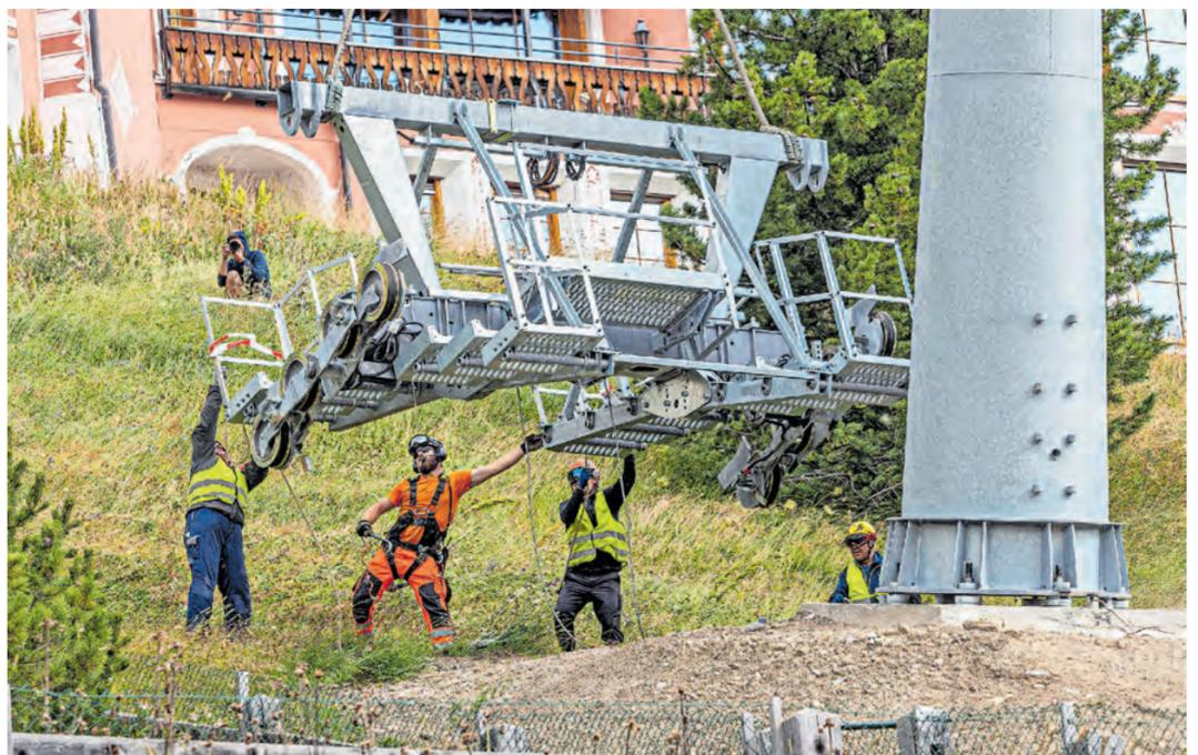
Der Super Puma der Heliswiss bringt die neuen Rohre und Rollenbatterien der Sesselbahn Suvretta. Dabei ist für den reibungslosen Ablauf die Kommunikation zwischen den Teams am Boden und dem Piloten von zentraler Bedeutung. Ein Prototyp der neuen Sessel kann im Hotel Suvretta House bereits besichtigt werden.
