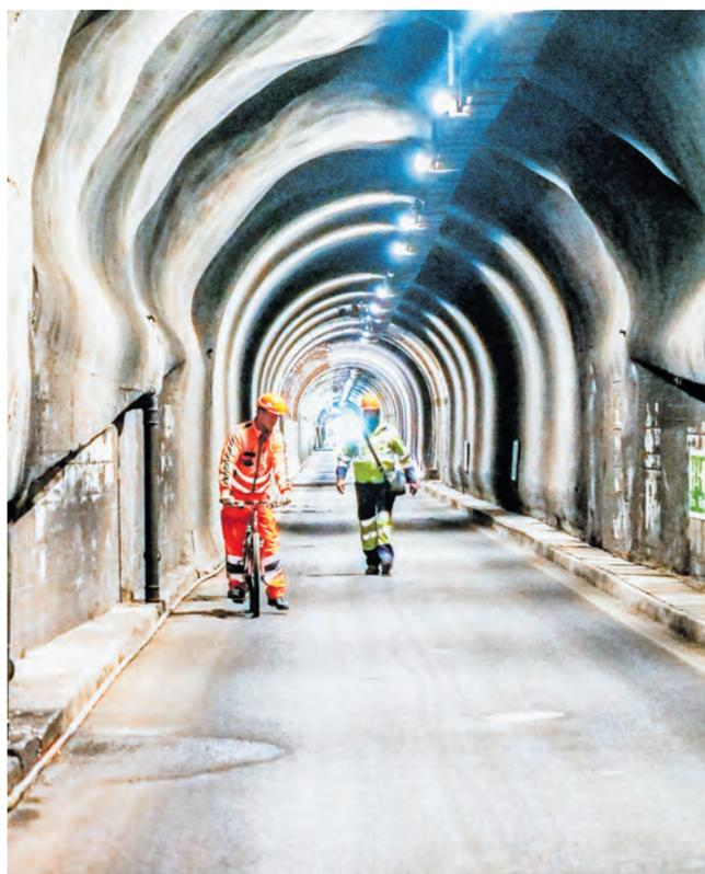
A dretta dal tunnel vain fabrichà in beton massiv ün bloc da büschens pellas lingias chi d'eiran fin uossa suot la via.
