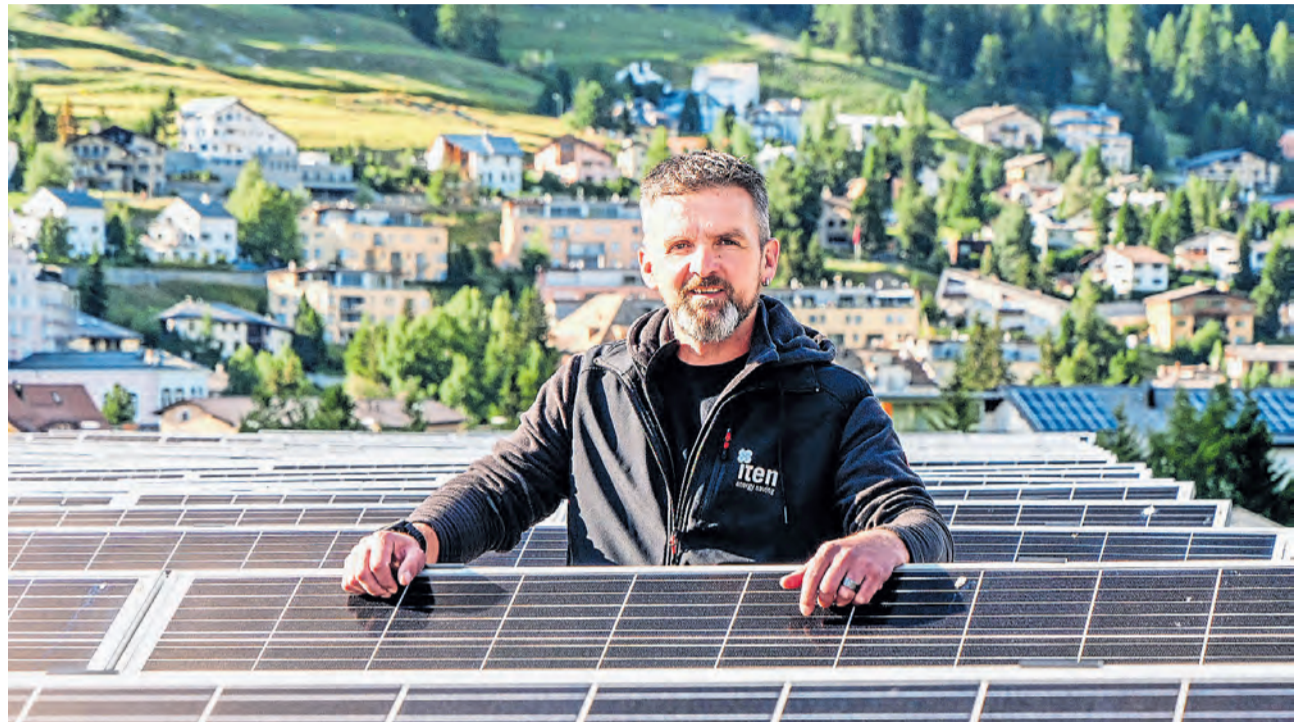
Marco Iten mitten in der PV-Anlage auf dem Dach der Porta Samedan, bei welcher er technischen Support leistete.
