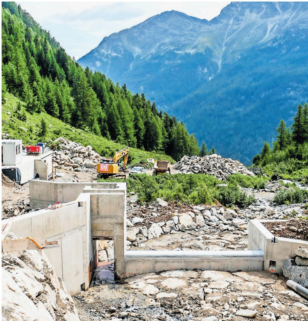
Blick auf die neue Wasserfassung der Ova da Sarsura zwischen Zernez und Susch samt noch offener Spülrinne. Im Hintergrund links die neue Entsandungsanlage von Wasserfassung und Trinkwasserversorgung. Foto: Jon Duschletta
