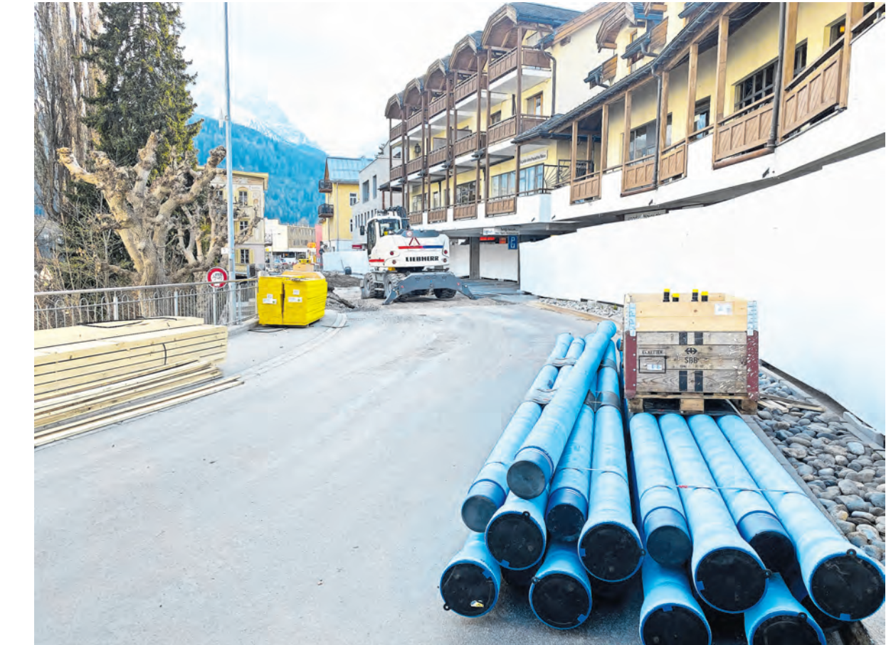
Actualmaing vain realisada l'ultima etappa da la renovaziun da l'infrastructura dal Stradun a Scuol. Tuot il proget d'infrastructura sül Stradun ha düra var desch ons.
