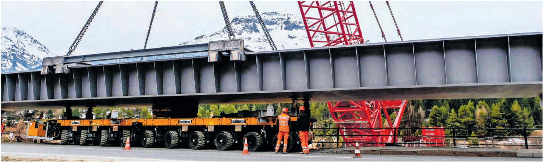
Die neue RhB-Flazbachbrücke hat eine Länge von 35,5 Metern, eine Spannweite von 34 Metern, ist gut sechs Meter breit und mit 180 Tonnen drei Mal so schwer wie die alte Fachwerkbrücke. Foto: Jon Duschletta
