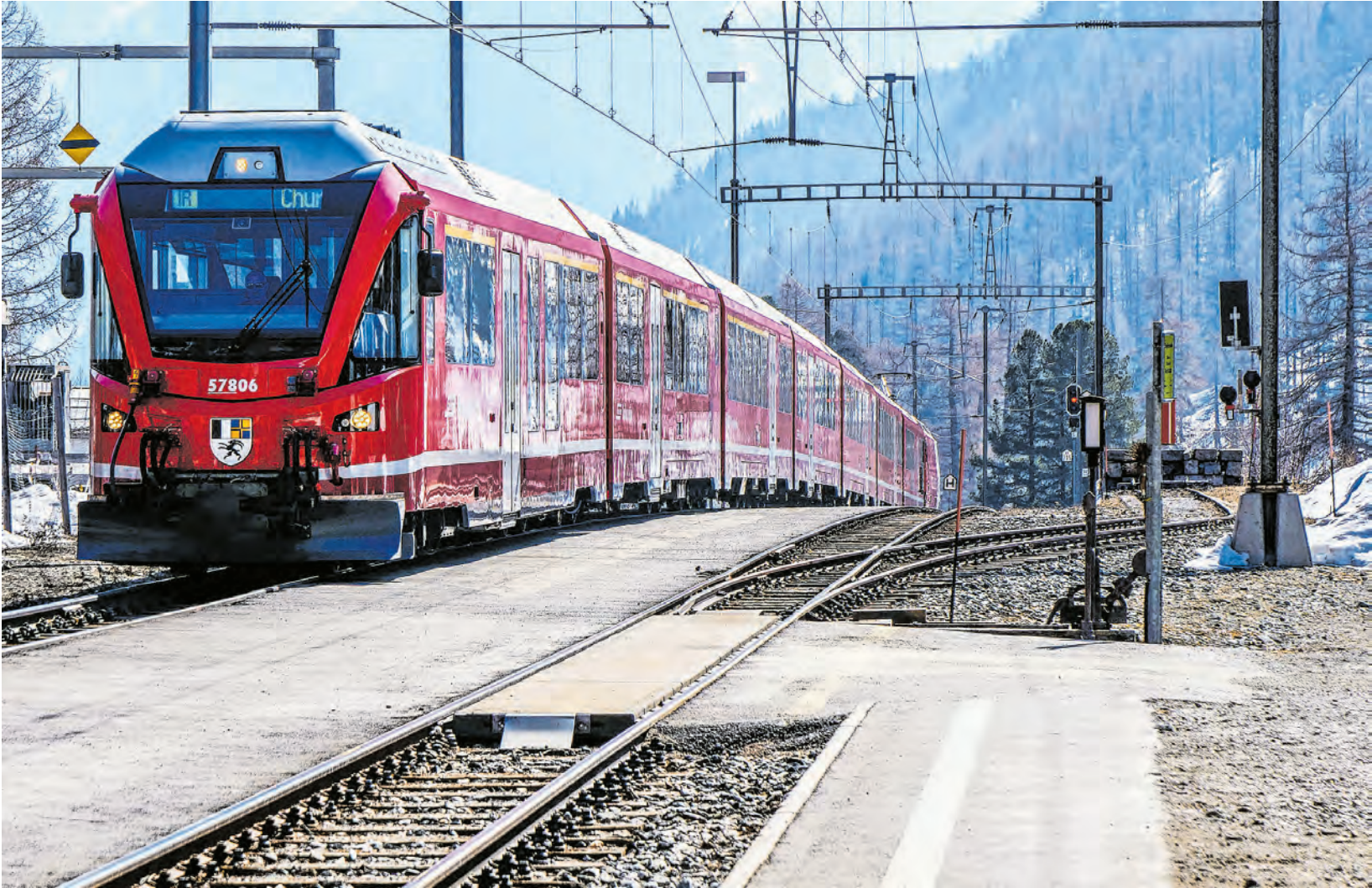
Bis 2023 wird die bestehende Gleisanlage in Spinas in zwei Etappen umgebaut. Bahnhofseitig (Gleis in der Bildmitte) wird ein neues, 300 Meter langes und behindertengerechtes Perron erstellt. Das Stumpengeleise (rechts) kommt auf der anderen Seite der Gleisanlage zu stehen. Fotos: Jon Duschletta
