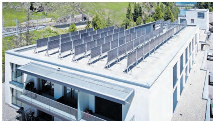
25 Kilowatt-Peak Leistung liefert die 2017 von St. Moritz Energie erstellte bifaziale PV-Anlage auf dem sanierten Wohngebäude.
