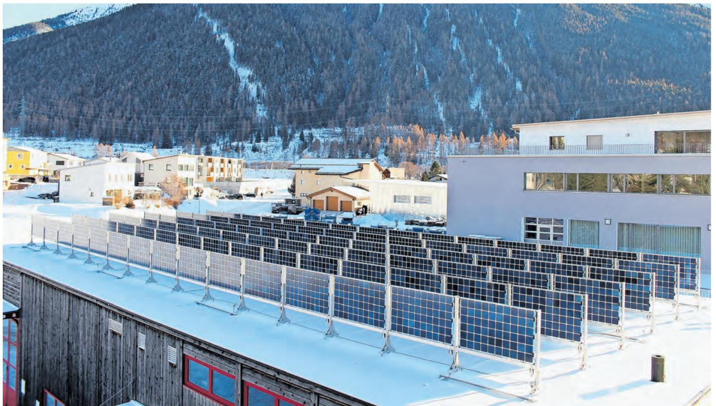
Die neue bifaziale Photovoltaik-Winterstromanlage der Engadiner Kraftwerke AG in Zernez liefert mit 90 Modulen 28,4 Kilowatt-Peak Leistung. Foto: EKW Zernez
