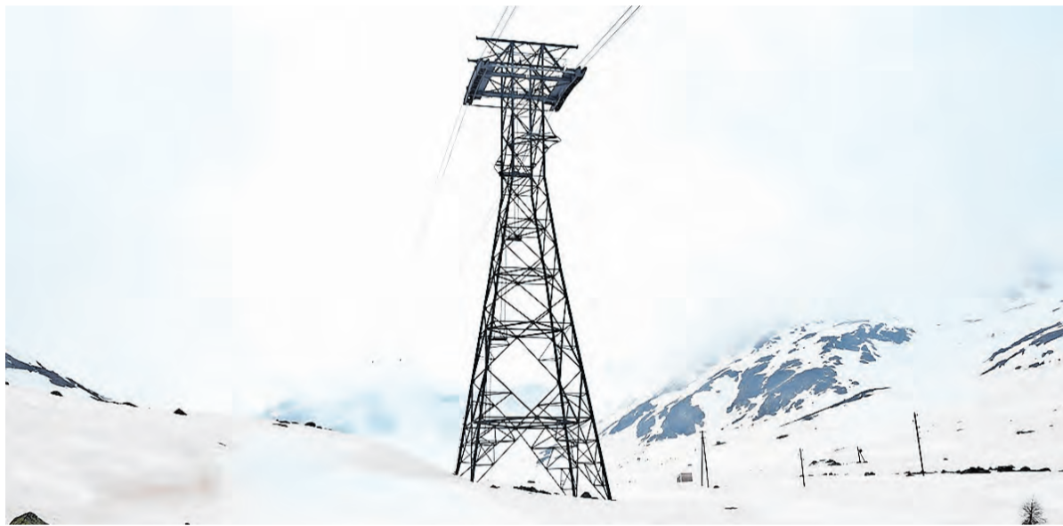
Von diesem Mast der Diavolezza-Seilbahn ist der Techniker gestürzt.
