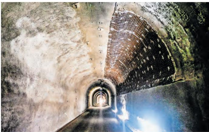
Von links: Punktueller Ausweitungen am Tunnelgewölbe und Frostschäden an der Spritzbetonschale bedürfen auch mal schwereren Gerätschaften.
