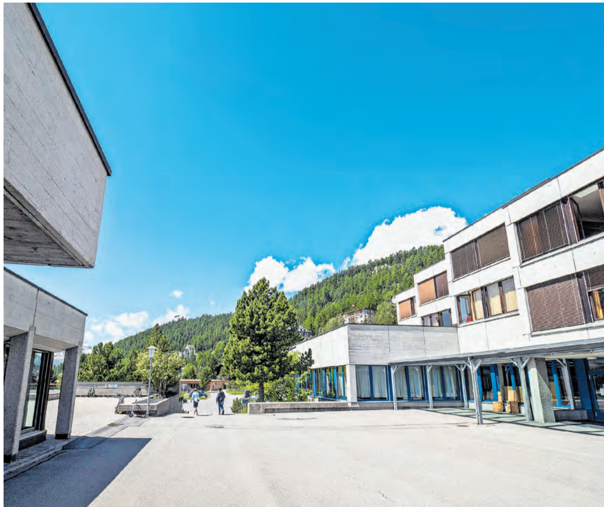
Das Schulhaus Grevas in St. Moritz dürfte nicht so rasch einem Neubau Platz machen. Zusätzliche Abklärungen sollen über das weitere Vorgehen entscheiden. Auch die Standortfrage soll noch einmal geprüft werden. Foto: Daniel Zaugg
