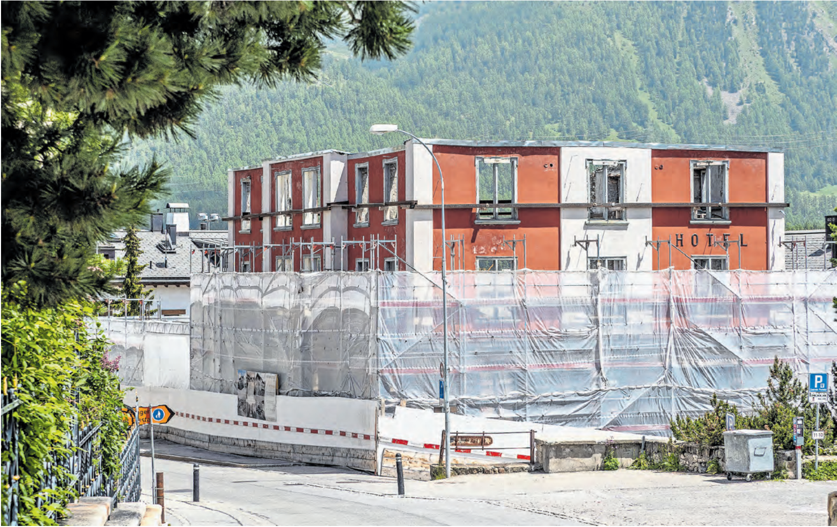
Eine luftige Sache: Seit im Frühjahr 2018 mit dem Abbruch des früheren Hotels Misani begonnen worden ist, steht im Dorf ein Hotelgerippe. Seit bald zwei Jahren wird nicht mehr gebaut. Ob, und wenn ja, wann es weitergeht, ist offen. Foto: Daniel Zaugg
