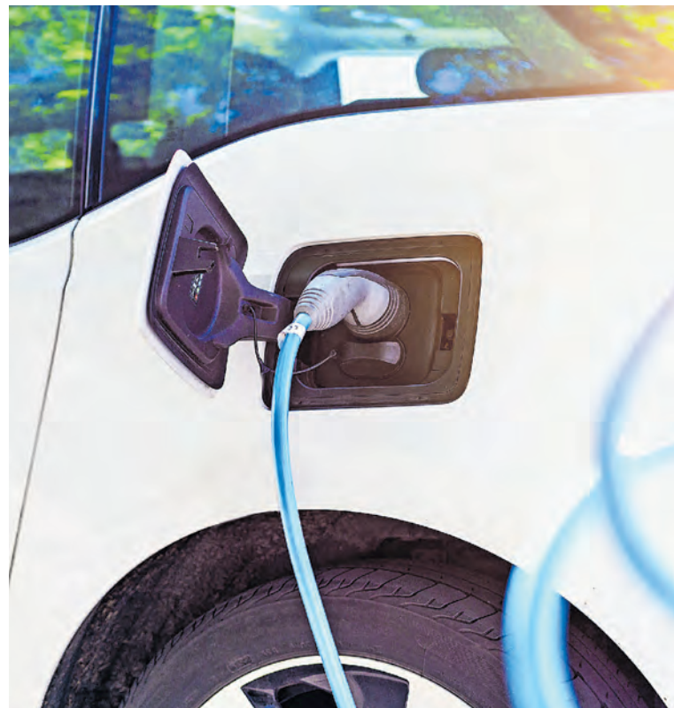
Zwei Gemeindeparkplätze werden in La Punt mit einer Ladestation für Elektrofahrzeuge eingerichtet.
