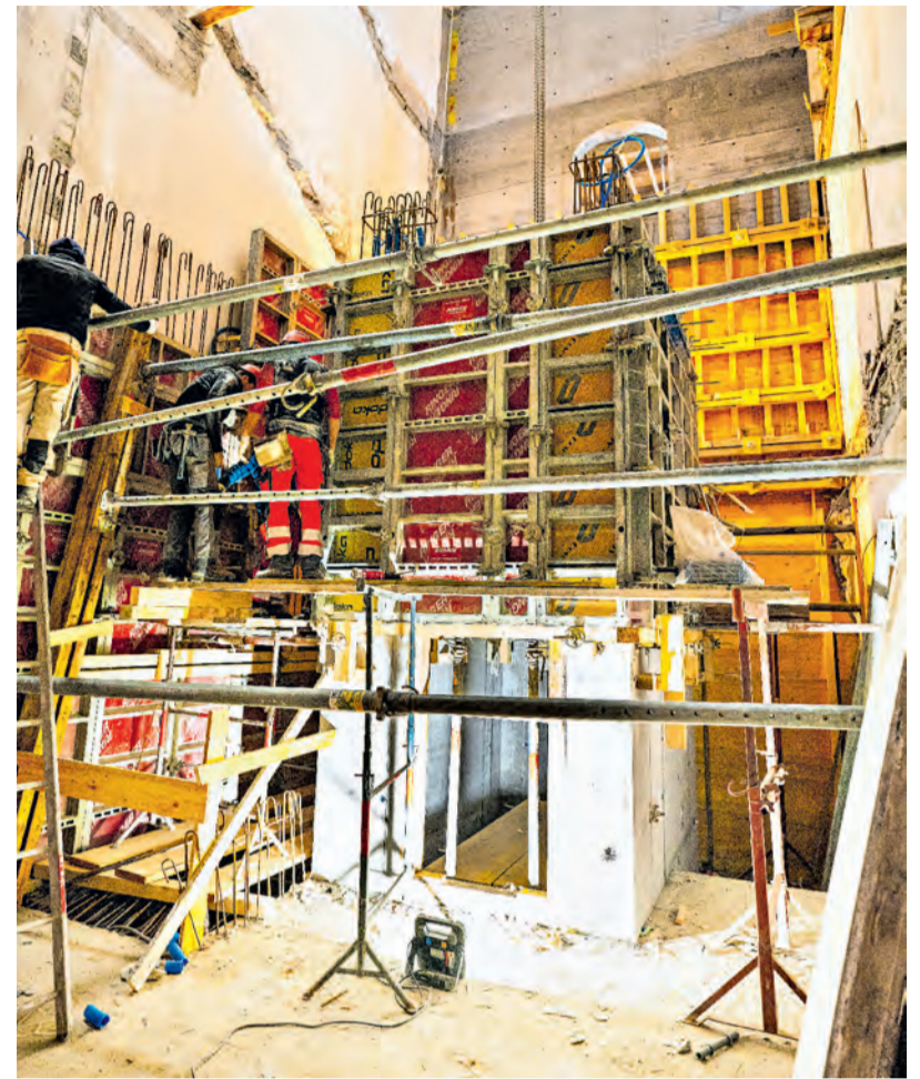
Vor allem der Einbau des neuen Lifts erweist sich als knifflige Angelegenheit. Fotos: Andrea Furger/Parkhotel Margna
