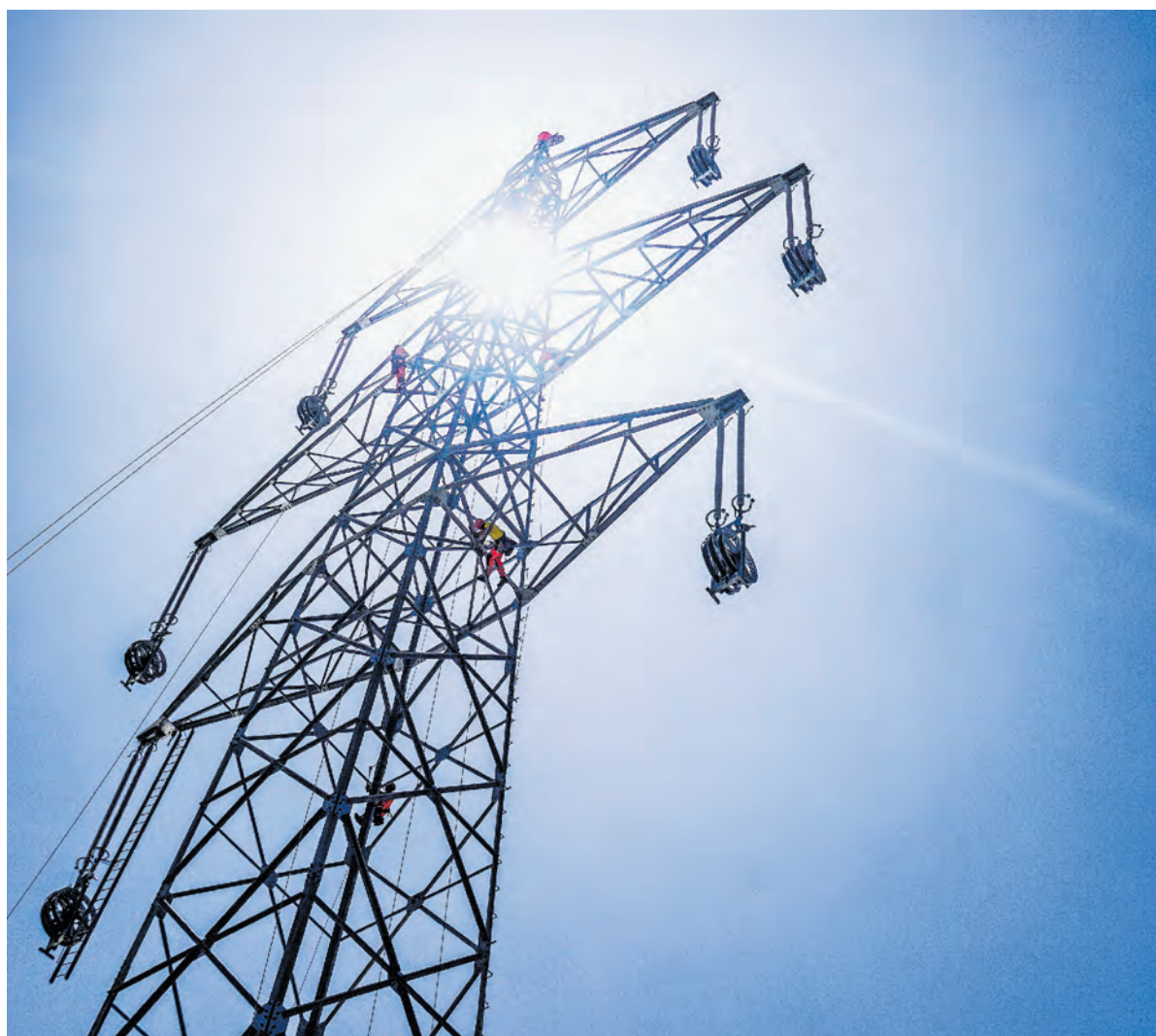
Die Schweizer Netzbetreiberin Swissgrid sorgt, wie hier beim Ersatzbau neuer Masten auf der Albulapasshöhe 2019, für funktionierende und stabile Höchstspannungsleitungen. Foto: Jon Duschletta
