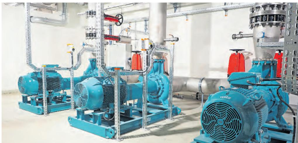
**Blick in das Innere, wo es nicht an Röhren fehlt, die das Abwasser leiten. Mittels drei Pumpen kann das gereinigte Wasser zur Stromgewinnung ausser Haus weitergepumpt werden.**
