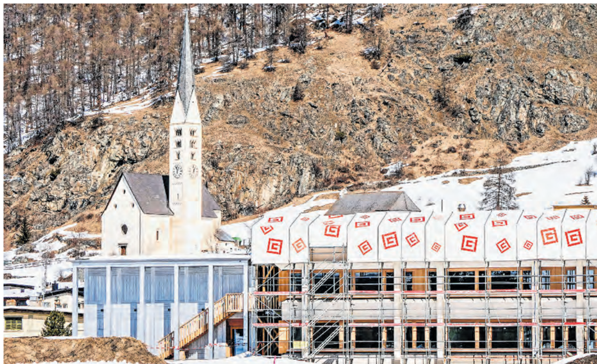
An der Schule Zernez wird gebaut, aber nicht getestet.
