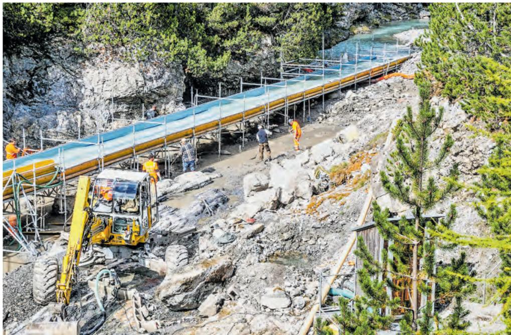
Wie aufwendig eine PCB-Sanierung in der Praxis ist, zeigte sich 2017, als das 60 Meter lange und stark PCB-belastete Tosbecken direkt unterhalb der EKW-Stauanlage Punt dal Gall erfolgreich saniert wurde. Foto: Jon Duschletta
