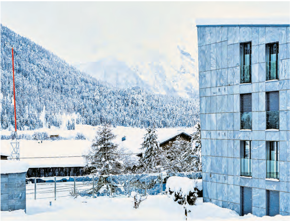
Die rot nachgezogene Bau-Profilstange der geplanten 5G-Antenne vom Spital Samedan her gesehen. Foto: Jon Duschletta
