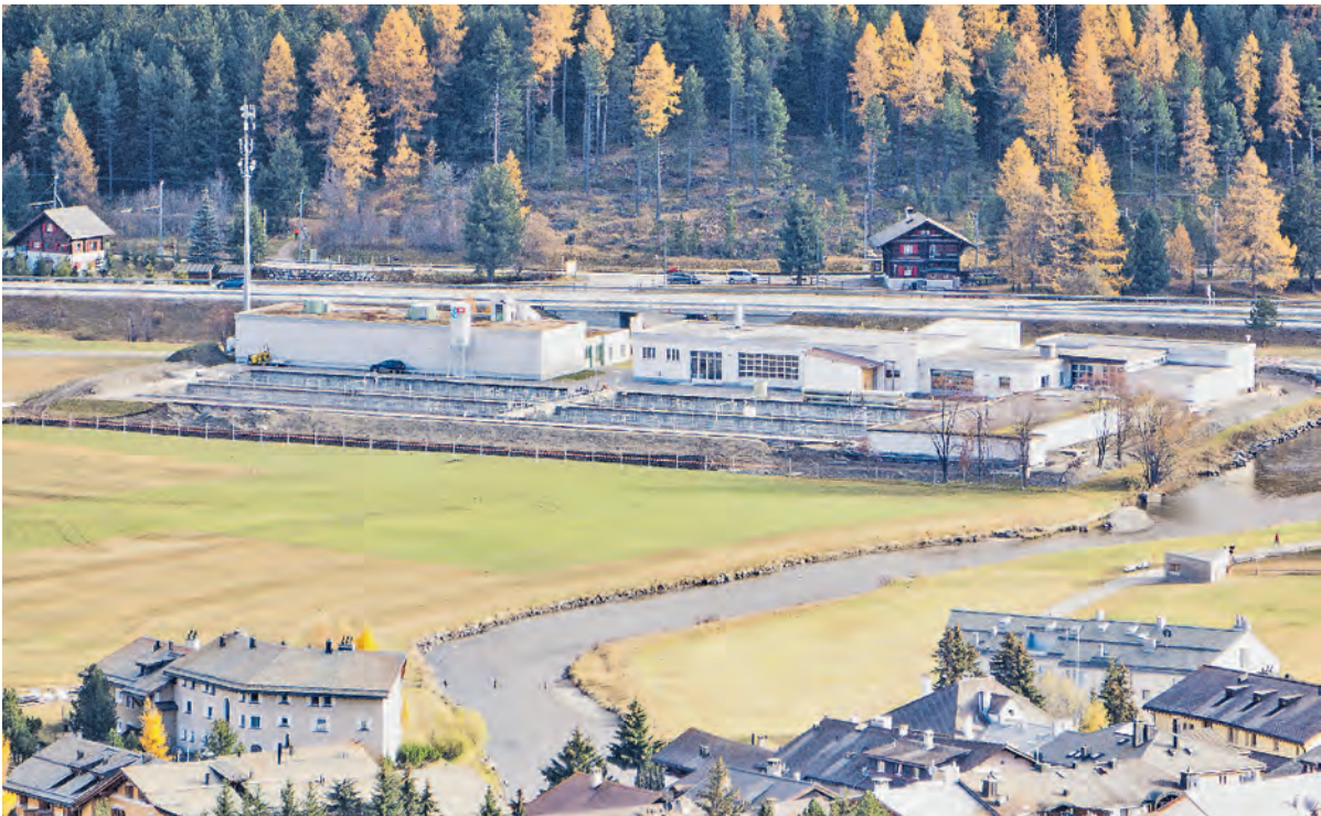
Die ARA Staz in Celerina wird bald zurückgebaut. Noch sind sich die Gemeinden nicht einig, in welchem Detaillierungsgrad. Foto: Reto Stifel
