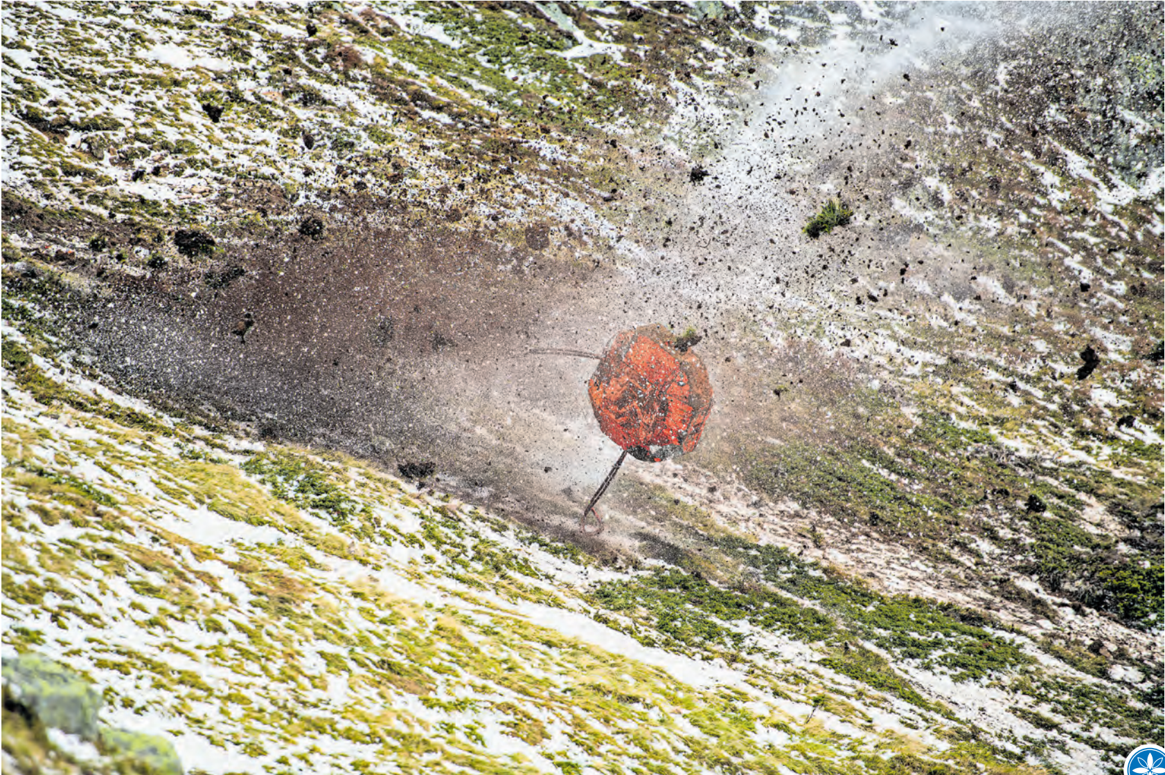
Bis zu 3,2 Tonnen schwere Betonsteine rollen am Flüelapass den Hang hinunter, um die Qualität der Steinschlagnetze zu testen. Mit der «EngadinOnline»-App kann das Video hinter diesem Bild aktiviert werden.
