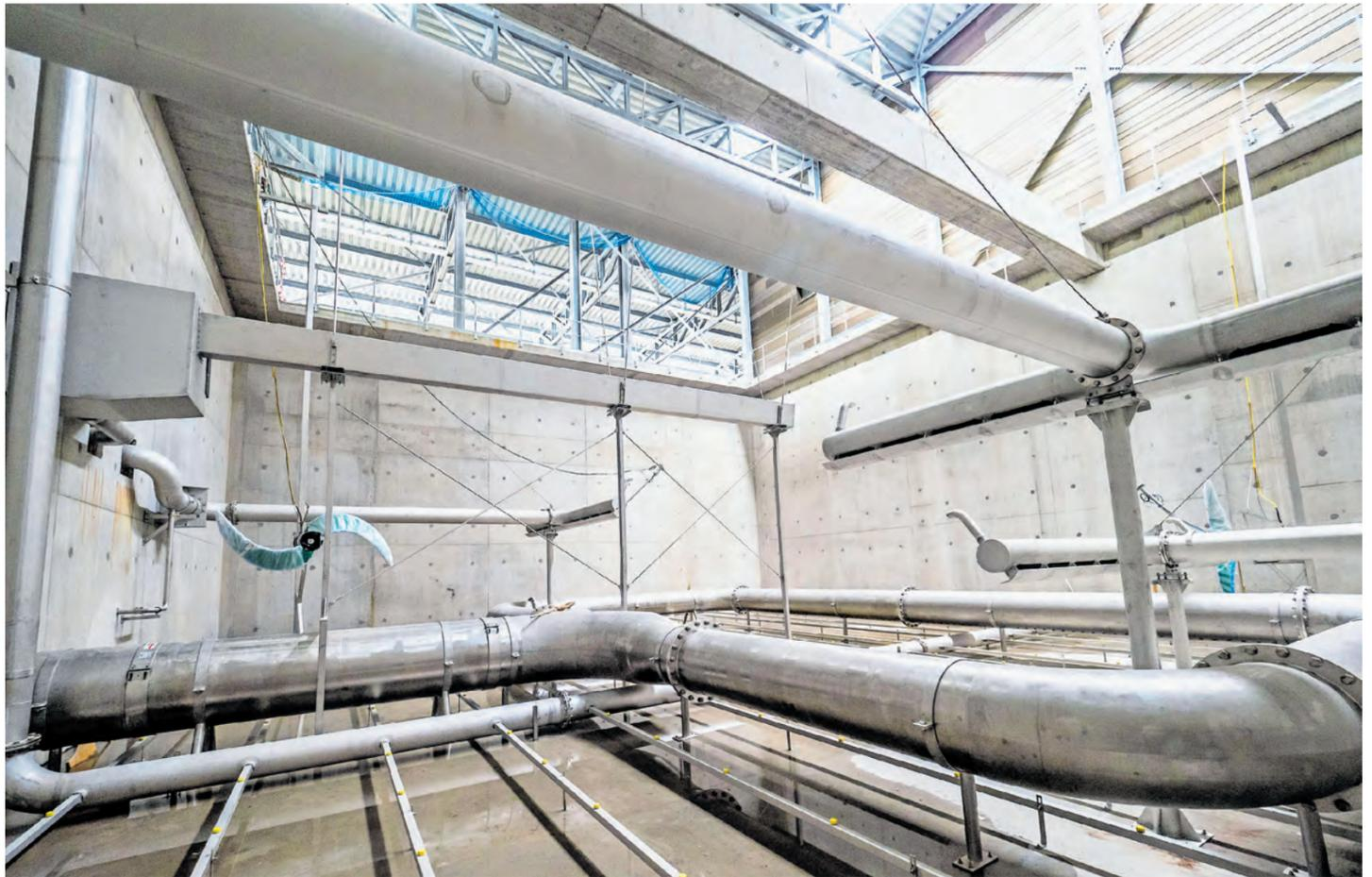
Das Innere einer der fünf «Sequencing Batch»-Reaktoren für die biologische Reinigung des Oberengadiner Abwassers.
