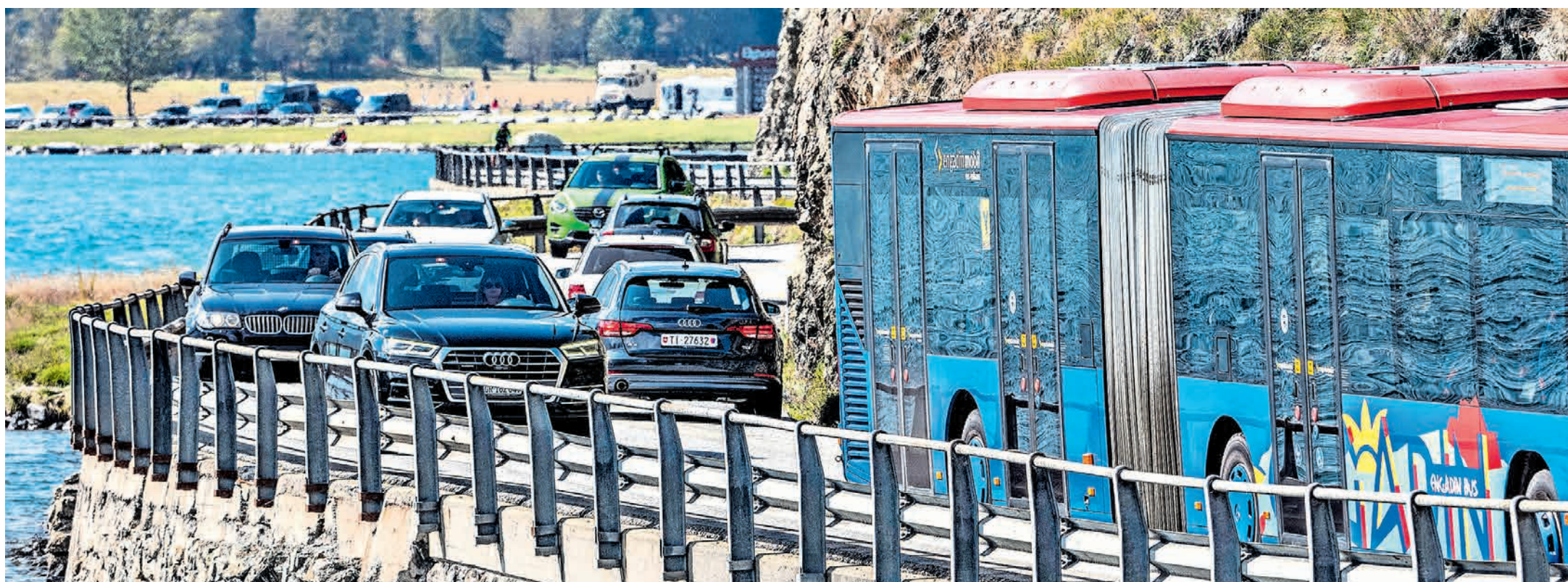
Es ist eng auf der Kantonsstrasse zwischen Silvaplana und Sils. Der Kanton will eine umfassende Sanierung und einen Ausbau der Strasse realisieren. Die veranschlagte Bauzeit beträgt acht Jahre. Foto: Daniel Zaugg
