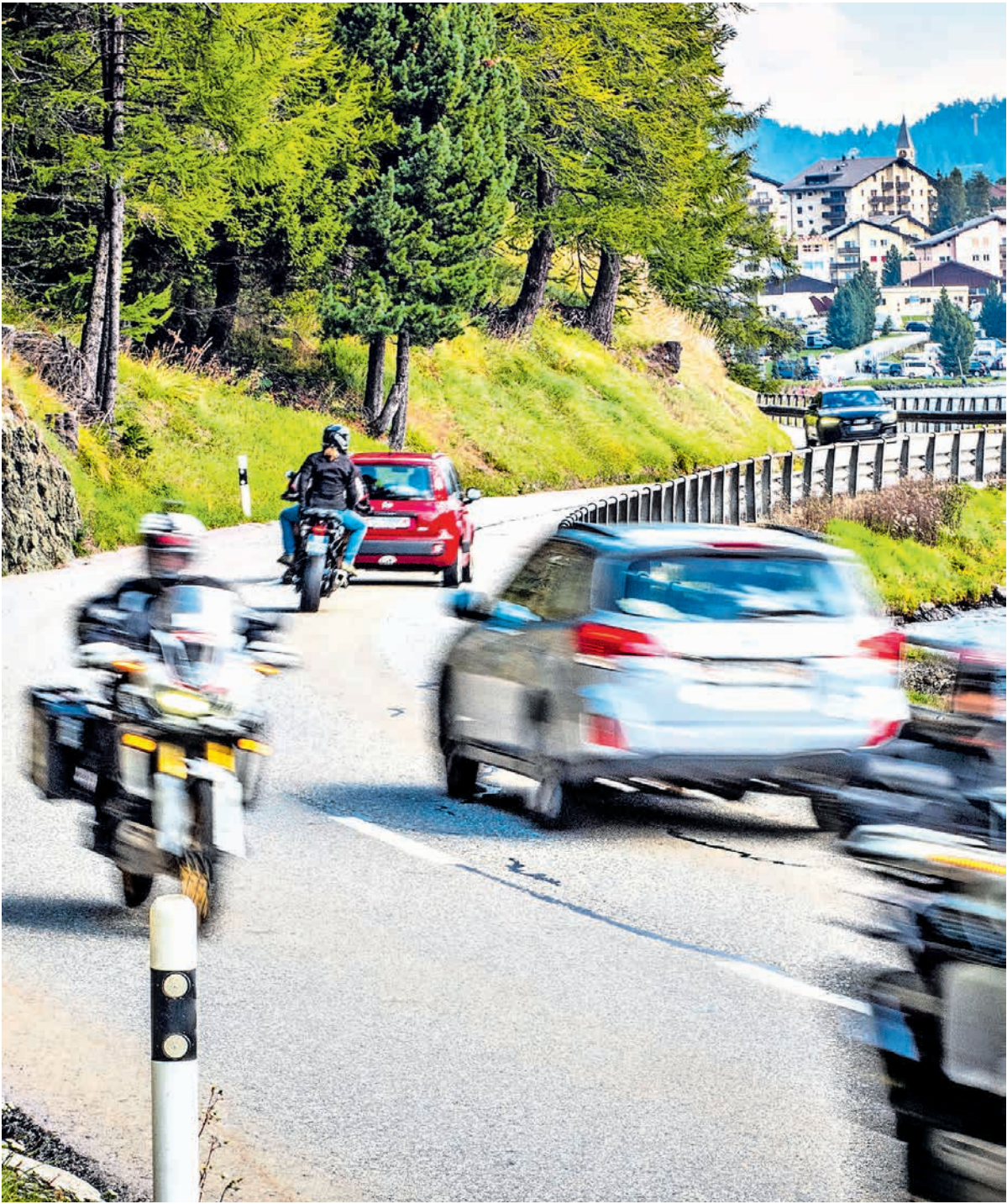
Eng, kurvig, unübersichtlich, stark befahren und in einem sehr schlechten Zustand: Der Strassenabschnitt zwischen Silvaplana und Sils muss dringend saniert werden. Über das Wie gehen die Meinungen auseinander. Foto: Daniel Zaugg
