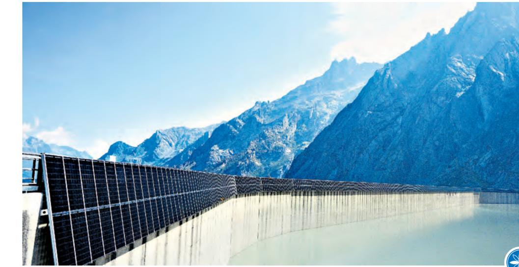
Solarpaneele auf der nach Süden ausgerichteten Wasserseite der Staumauer Albigna.
