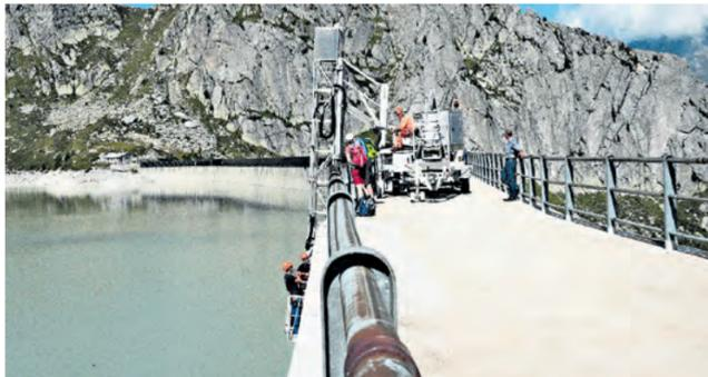
Mit einer Hebebühne werden die Bauarbeiter auf die Mauer gehievt, wo die Solarmodule in eine Halterung eingeschoben werden.
